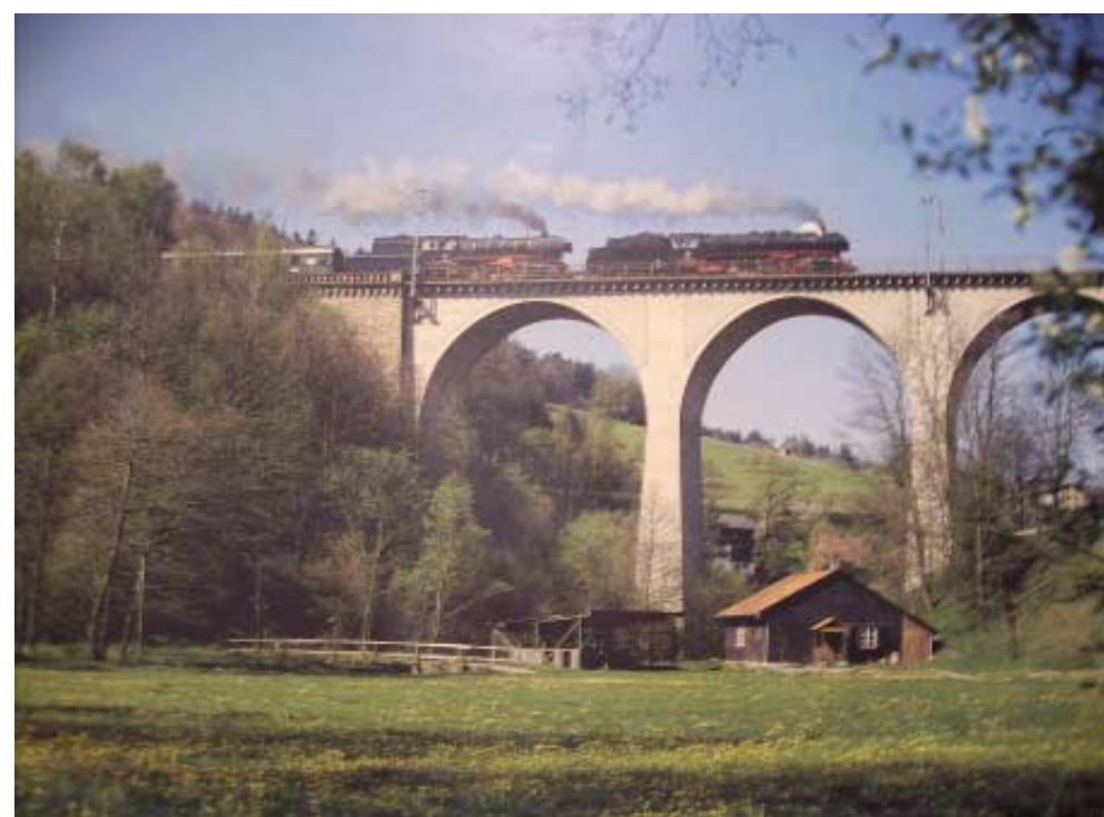
An der Mündung der Jossa in die Sinn quert ein Viadukt das Tal bei Jossa.
