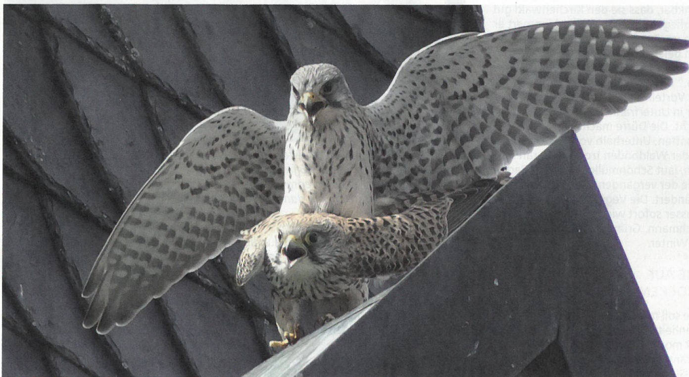
Ein Loch im Mauerwerk der Obersinner Kirche wählte ein Turmfalken-Pärchen als Wohnung für seine Brut aus.
